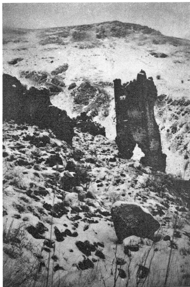
تصویر شماره ۱۰: ساختمان سه اشکوبه داخل قلعه بردوک
